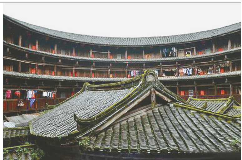
怀远楼内为木构架，土坯砖隔墙。第一层为厨房，第二层为谷仓，第三、四层为卧室。楼直径42米，每层34间，内通廊式。王渝摄
